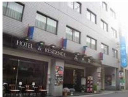
←ホテル&レジデンス南洲館施設外観
