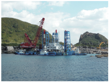
工事の様子（小宝島港）▲
