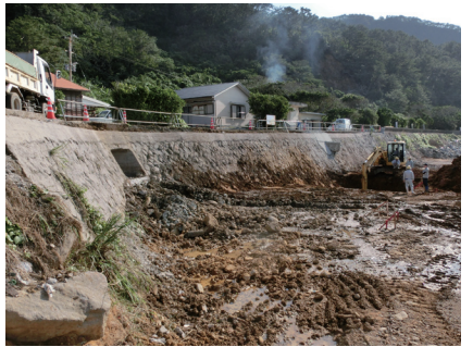
工事の様子（中之島海岸線）▲
