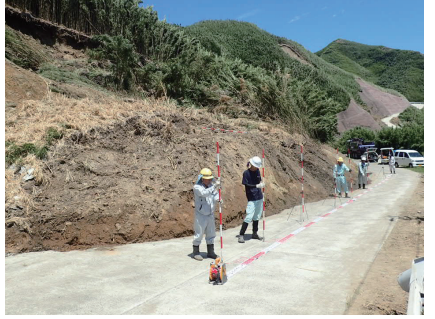
工事の様子（平島高原線）▲
