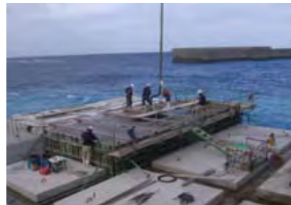
▲小宝島港施工中の様子
