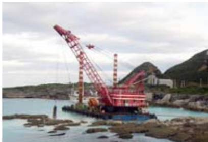
▲小島島港泊地(-5.5m)浚渫工事の様子
