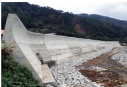
▲中之島海岸道路改良工事の様子
