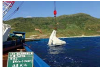
▲東之浜港改修工事の様子
