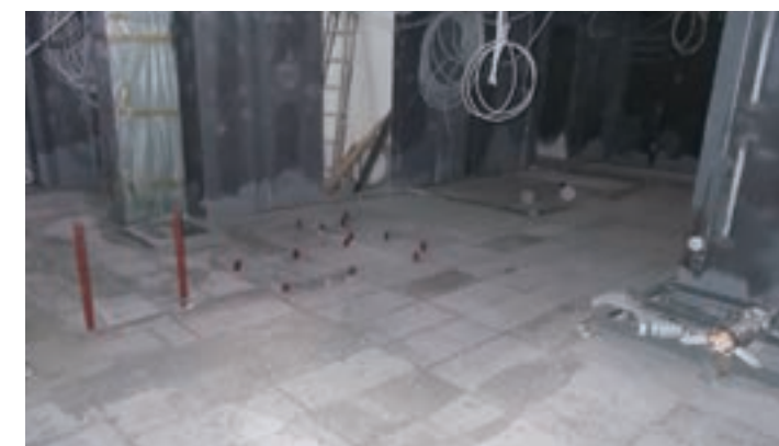
▲上甲板エントランス床舗装工事の様子
