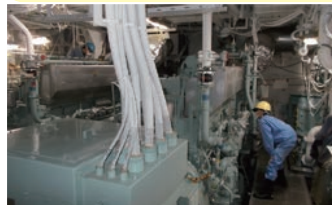
▲発電機試験の様子
