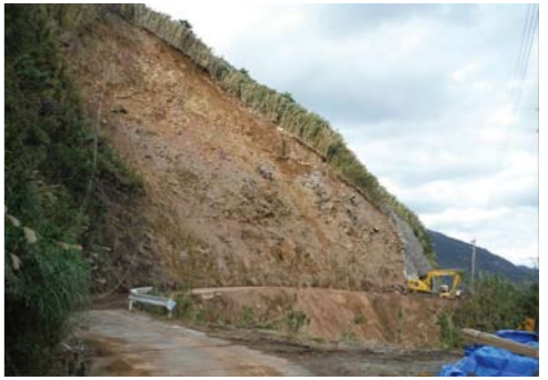
▲南廻線道路災害復旧工事の様子
