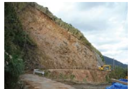
▲中之島南廻線道路災害復旧工事の様子
