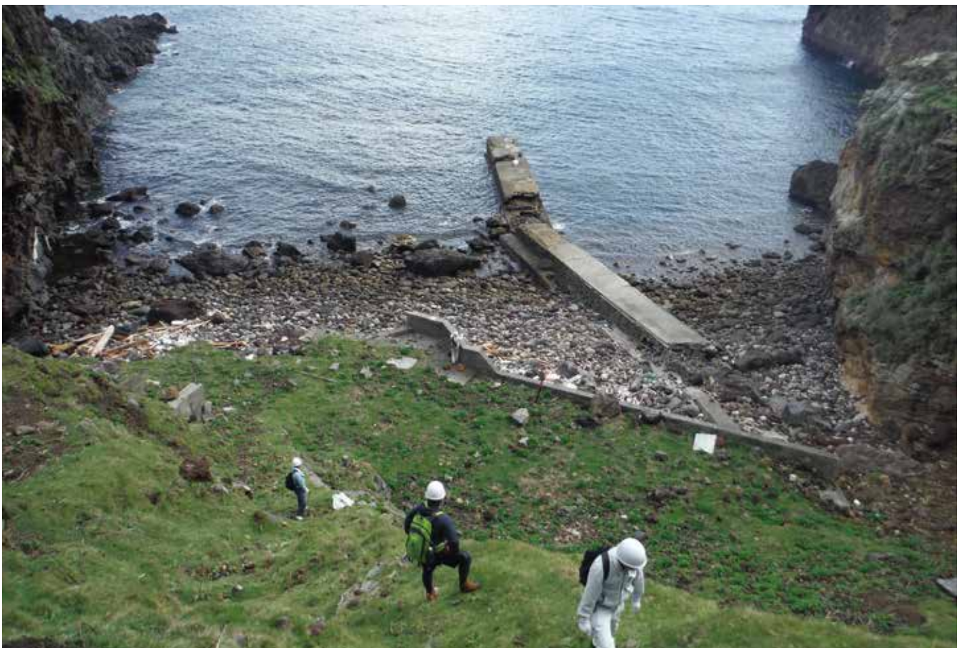
海岸にあった灯台倉庫(右)、集落倉庫(左)は僅かに基礎が残るだけ
