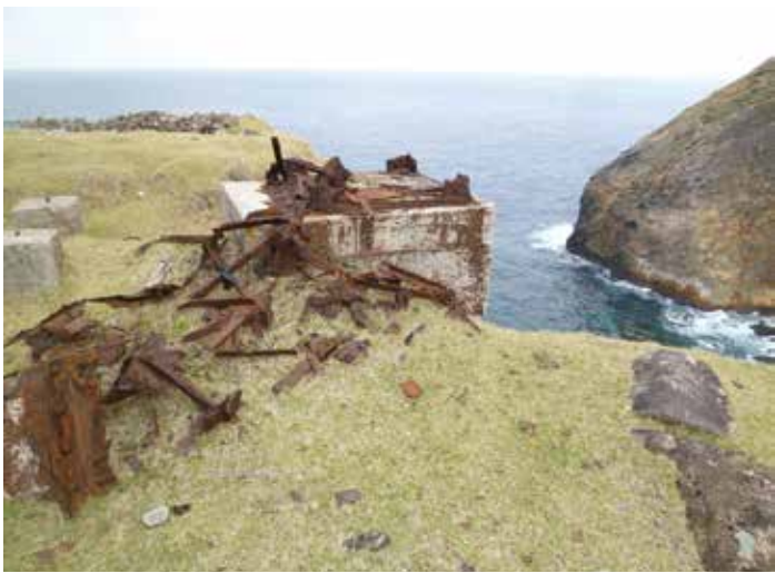
索道用の鉄塔跡(集落と港をワイヤーで結んでいた)
