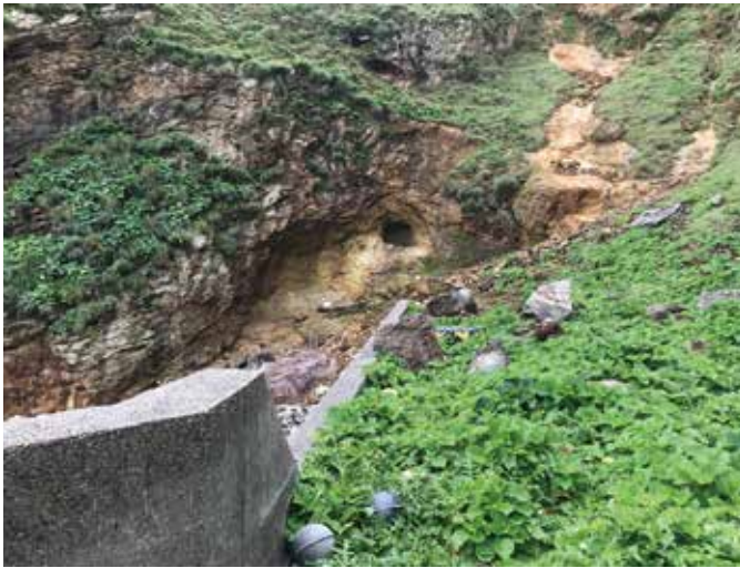
港湾工事に使用する爆薬を保管するために掘った穴
