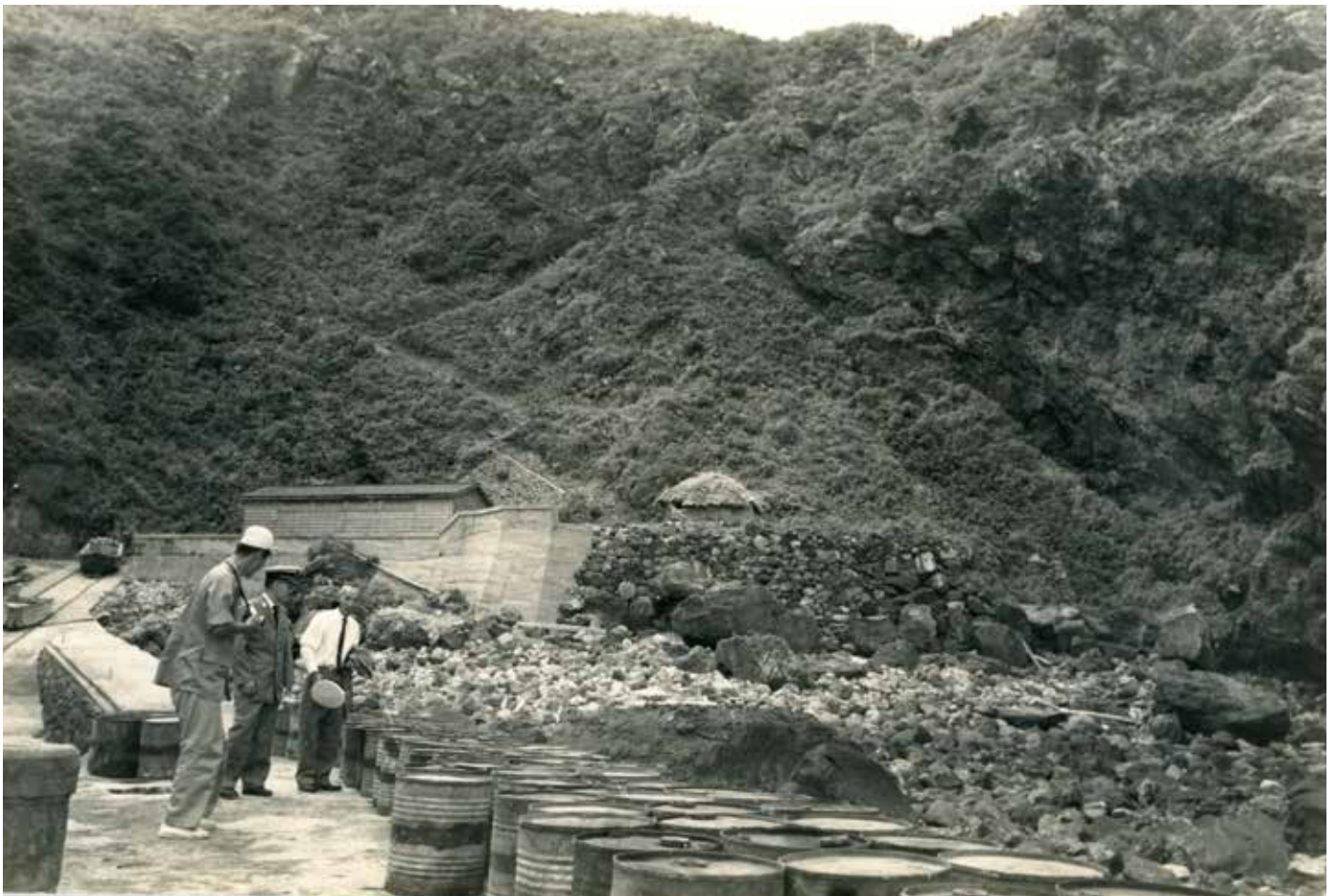
灯台補給船「若草」から降ろされた灯台燃料用のドラム缶。 背後の左の建物は灯台の倉庫、右は集落の倉庫
