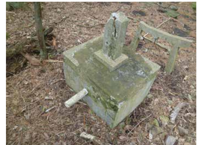
背面の穴にパイプが埋め込まれている
