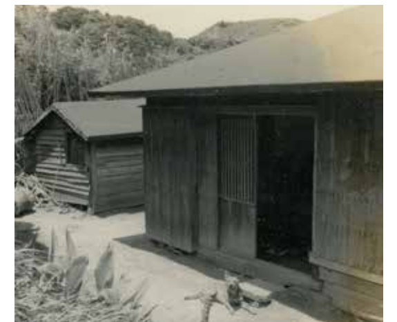
立派な木造住宅、入口には犬も
