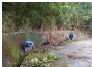
←汚れた側溝の掃除
