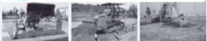
鹿児島市東部のトラクターショベル(タイヤ式) ブルドーザーによる押土作業 バックホー(0.25㎡)による掘削作業
